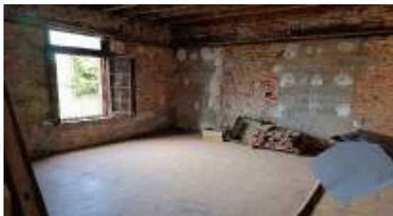
RDC logement 2 Séjour
