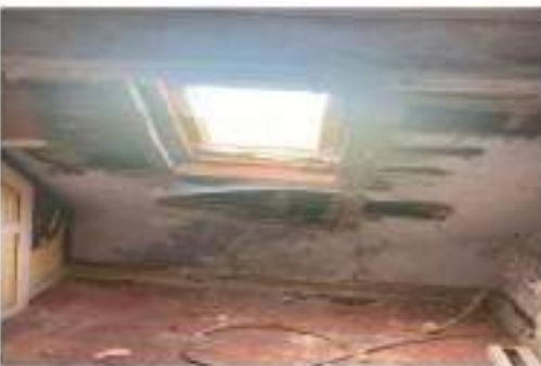
R+1 Logement 1 // Future Chambre 2
