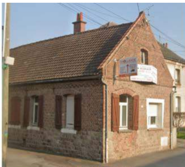
Photo du bâtiment existant
