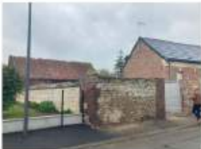
Façade de l'existant côté rue - façade avant
