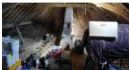
sous les combles
