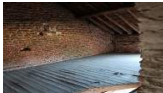
RDC logement 2 Future chambre 2
