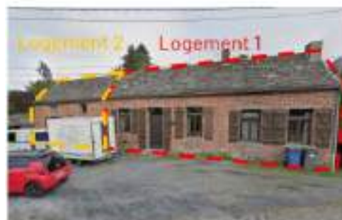
Façade de l'existant sur rue
