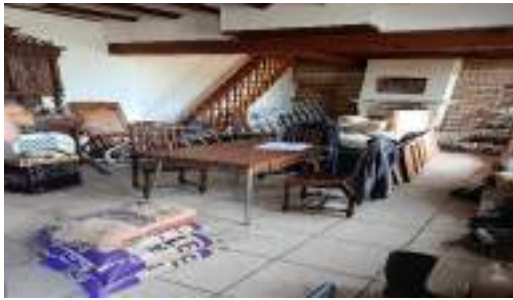
RDC logement 1 future salle à manger
