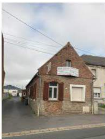
Façade de l'existant sur rue
