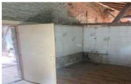
RDC Logement 2 // Future Chambre 1
