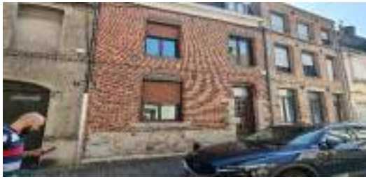
Façade du bâtiment existant
